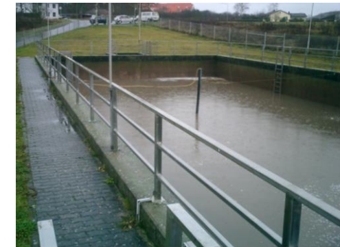
Beispiele eines Regenüberlaufs (links) und eines Regenüberlaufbeckens (rechts) in offener Bauweise Quelle: FG Siedlungswasserwirtschaft TU Kaiserslautern
