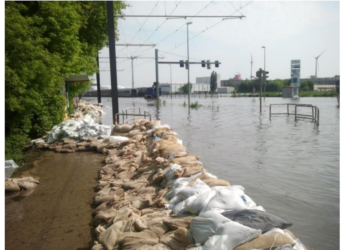
Sandsackwall zum Schutz des technischen Polizeiamts in Magdeburg Quelle: Jüpner (2013)
