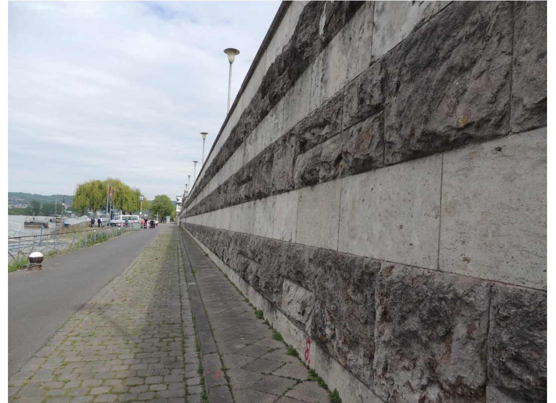
Beispiel einer Hochwasserschutzwand an der Uferpromenade Quelle: Gall (2015)
