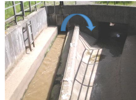
Beispiele eines Regenüberlaufs (links) und eines Regenüberlaufbeckens (rechts) in offener Bauweise Quelle: FG Siedlungswasserwirtschaft TU Kaiserslautern
