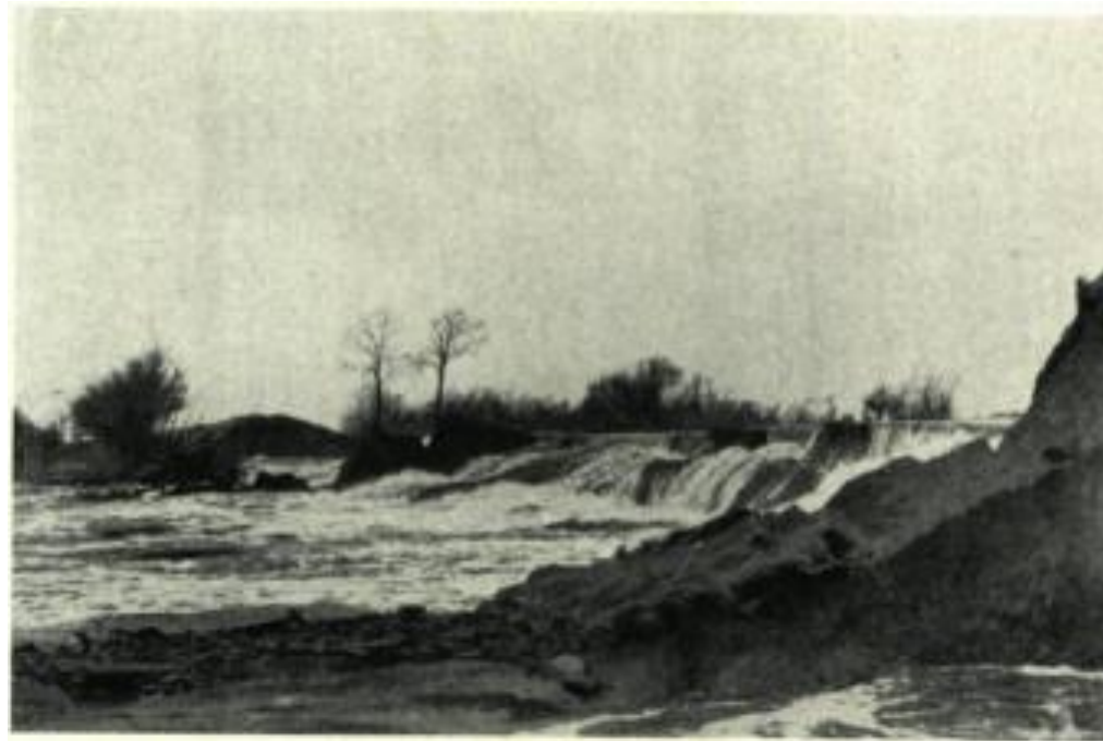
Deichbruch bei Cranz infolge der Sturmflut vom 16. / 17. Febr. 1962 Quelle: Bundesanstalt für Wasserbau (1962)
