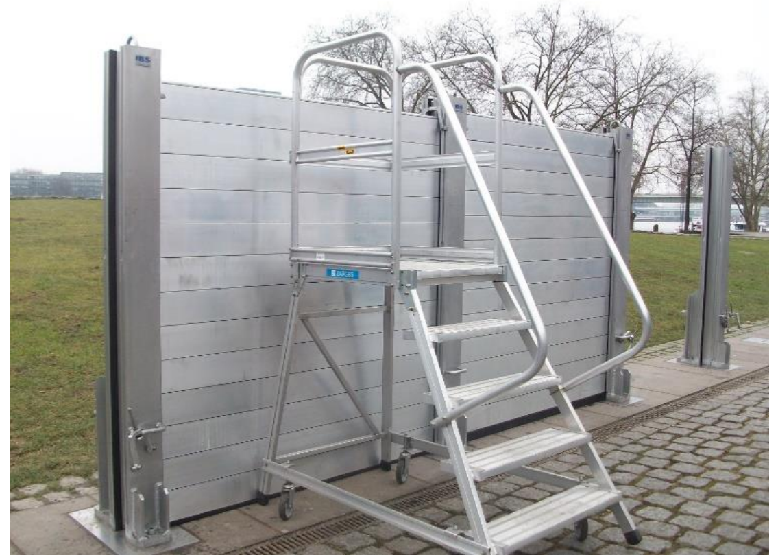
Aufbau einer mobilen Hochwasserschutzwand Quelle: Gall (2015)
